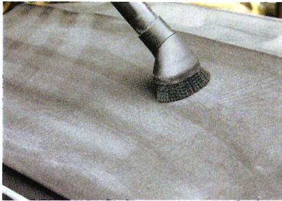
Den Anfang bildet eine gründliche Reinigung - am besten trocken mit Bürste oder Staubsauger
